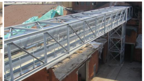
Bandbrücke mit Laufstegen
