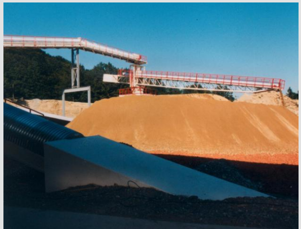
Bandabsetzer Rohstoffhalde, 50.000 to
