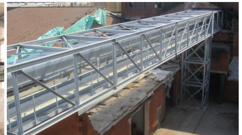
Bandbrücke mit Laufstegen
